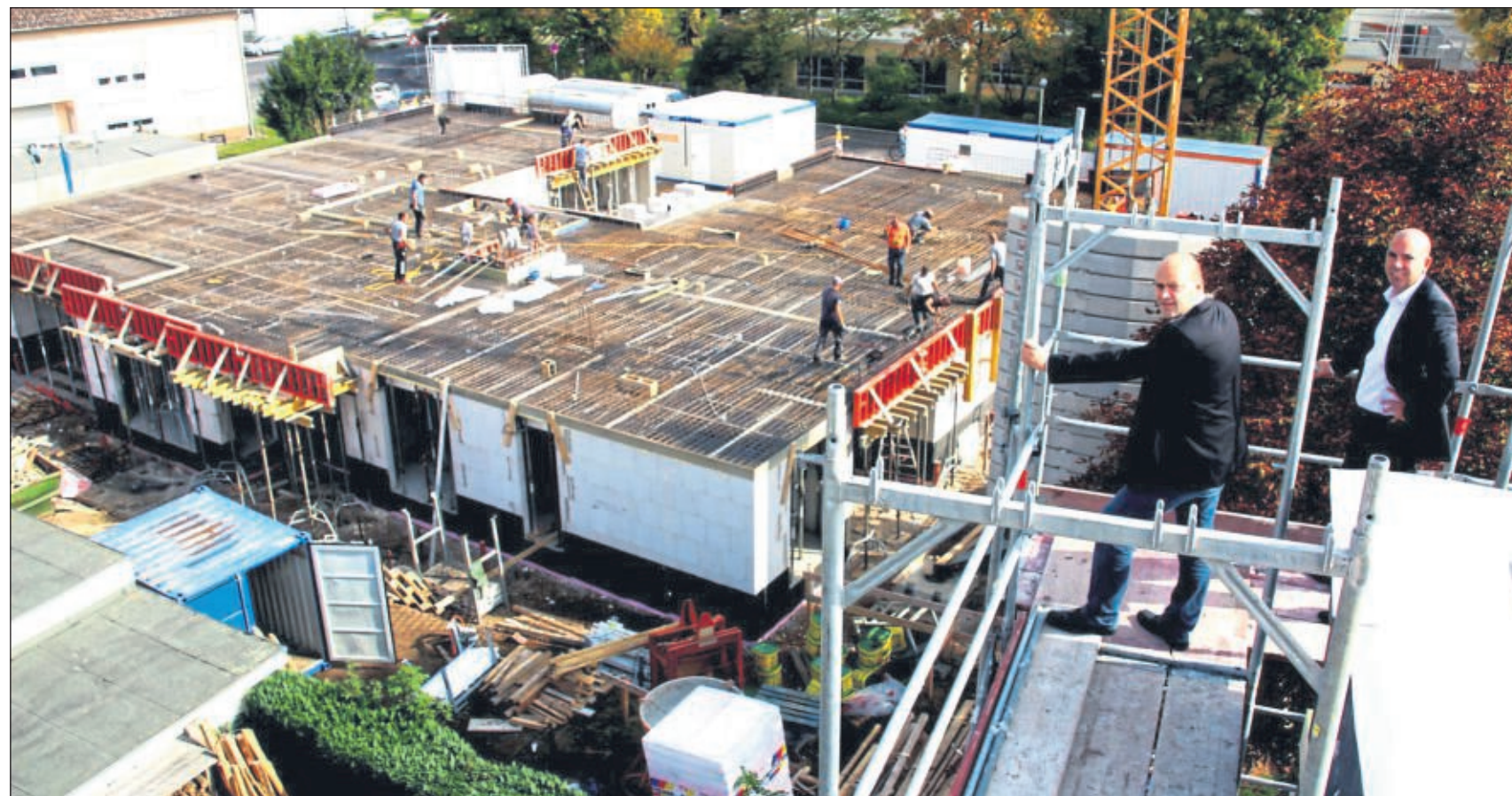
Bürgermeister Daniel Tybussek und Wohnbau-Geschäftsführer Ingo Kison auf dem Dach des Seniorenheims, das den Blick auf die Seewiesen-Baustelle erlaubt. ■ Foto: p
