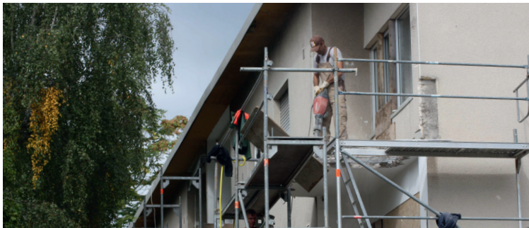
Aus den alten Balkonen am Dreispitz werden kleine Sonnenterrassen.
