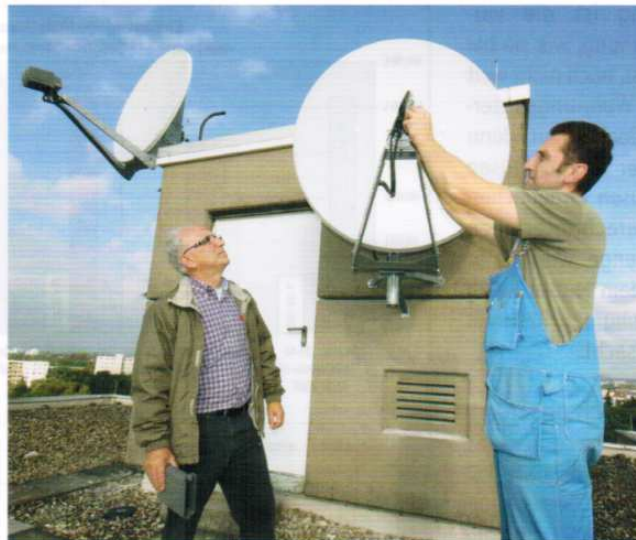
Alfons Ott (l.) Projektleiter der Immoservice Mühlheim GmbH, und ein Mechaniker bei der Endkontrolle der beiden großen Schüsseln auf dem Dach, die viele kleine Schüsseln an den Hausfassaden und Balkonen ersetzen. Quelle: Wohnbau Mühlheim
